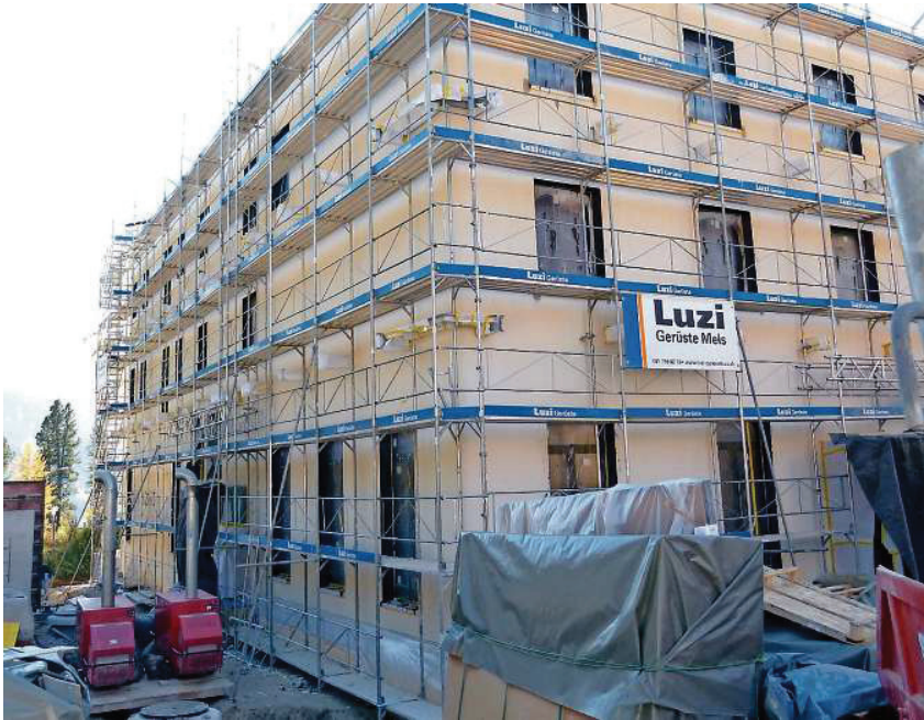
Mit dem Aufbringen des Verputzes verwandelte sich das ehemals helle Gebäude zu einem schwarzen. Die noch anzubringenden Gitterstäbe sollen die optische Verbindung zur HGK herstellen und zu einem hellen Gesamteindruck führen.
